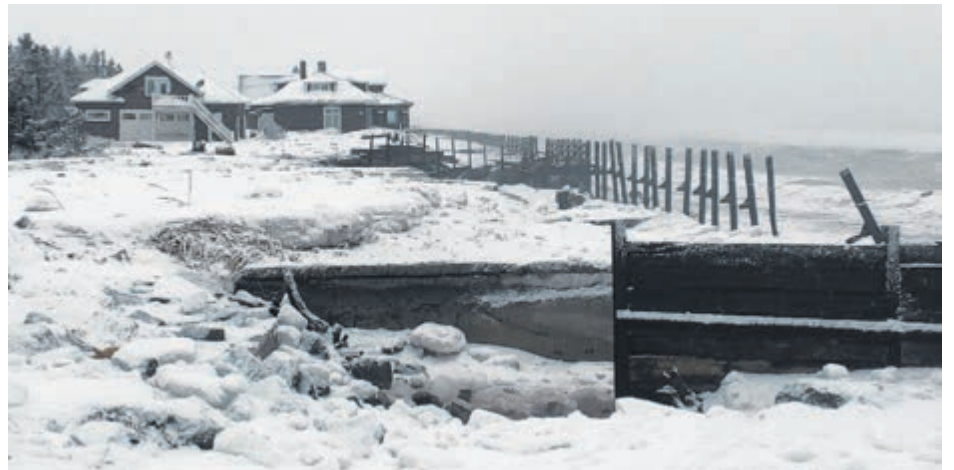
12 résidences et chalets situés le long de la rue de la plage ont été secoués et endommagés, parfois très sérieusement, alors que 9 personnes ont dû être évacuées.
