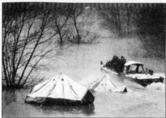
PONT —Les soldats américains du génie poursuivent l'installation d'un pont flottant sur la Save.
