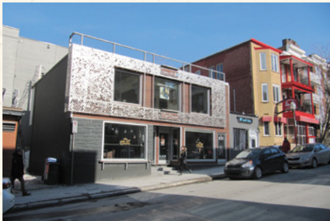
Le café Castelo, une rénovation originale d'une façade commerciale par l'agence STGM sur l'avenue Cartier, à Québec, qui utilise le bois et l'acier, en référence à une œuvre de la galerie d'art à l'étage. Source : © Vivre en Ville, tous droits réservés
