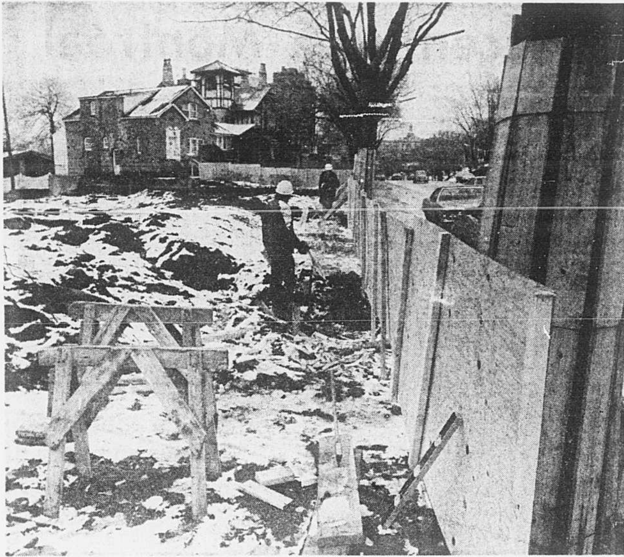
Les employés du chantier incriminé ont été forcés, dès hier matin, d'ériger une clôture de protection. Cette photo a été prise en fin de journée, après la visite des inspecteurs du gouvernement provincial.
