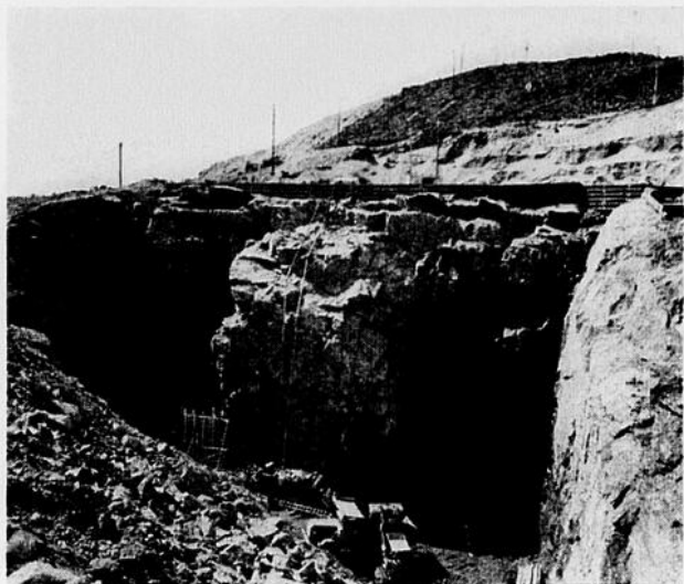
En gros plan, les bouches de tunnels de dérivation provisoire des eaux de la manicouagan que l'on est à percer afin d'assécher la lit où l'on procèdera à la fouille (nettoyage avant de couler le béton).
