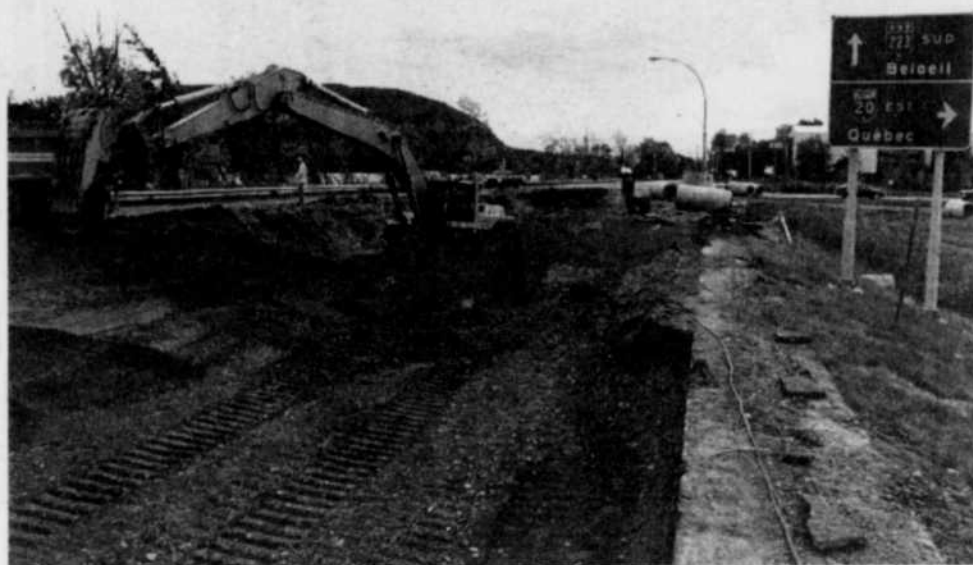
Les travaux près de la 20 seront prolongés de trois semaines parce qu'on a décidé de réaliser immédiatement des travaux qui devaient être accomplis l'an prochain.
