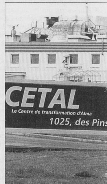
Les anciennes installations d'Alcan à Isle-Maligne, rebaptisées CETAL.
