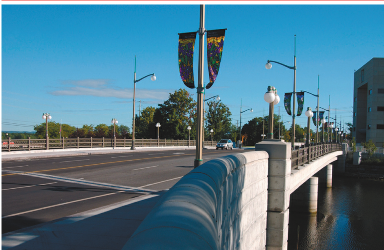
LES PONTS BYTOWN ONT RÉCEMMENT ÉTÉ REMIS EN ÉTAT.
