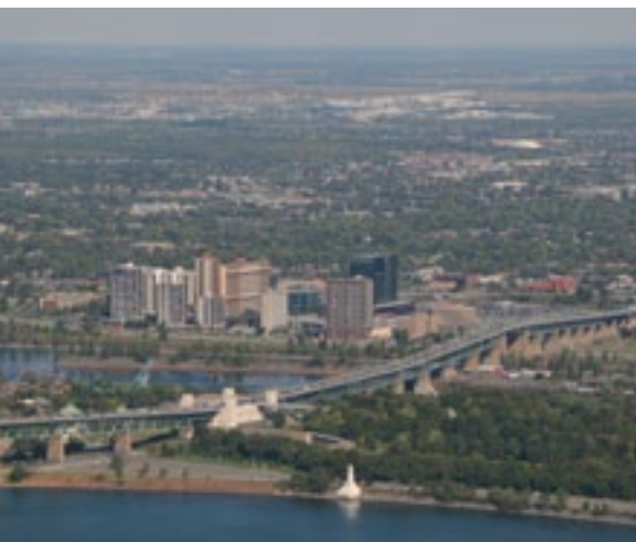
Vue aérienne du territoire de la ville de Longueuil, dont la Place Charles-Le Moyne où ont été effectués cette année des travaux de revitalisation majeurs qui se poursuivront en 2012.
