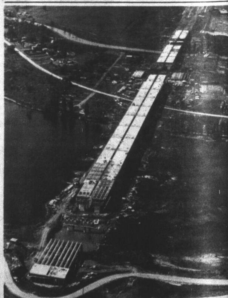
► Cette photo nous fait voir où en sont rendus les travaux du nouveau pont de l'autoroute de l'Est, qui enjambe la rivière Richelieu à mi-chemin entre Chambly et l'Île Ste-Thérèse.
