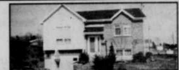
Rue Church, tout près du lac Boivin et centre-ville, profitez de sa pièce vitrée 3 saisons. Elle est impeccable et très fonctionnelle. 201-C408702
