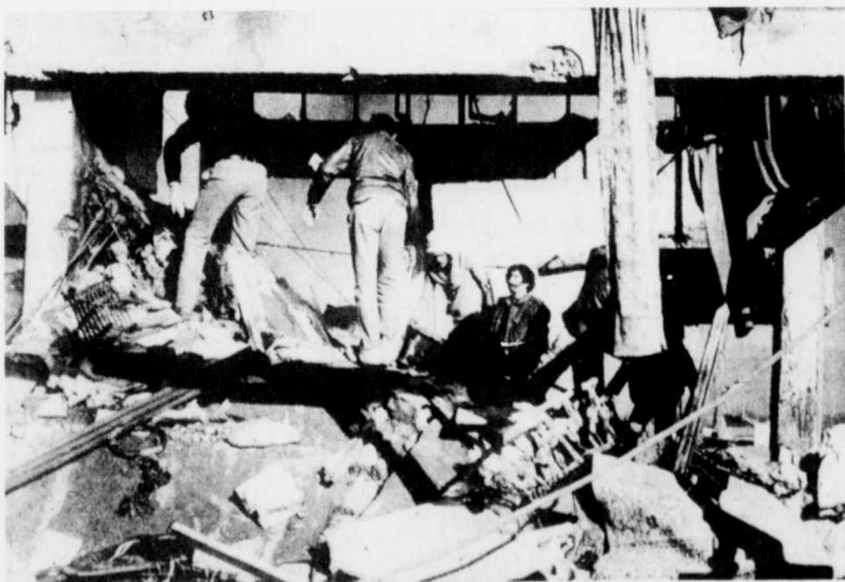
Dans l'espoir de découvrir des survivants, des civils libanais fouillent les ruines d'une maison touchée de plein fouet par une bom-
