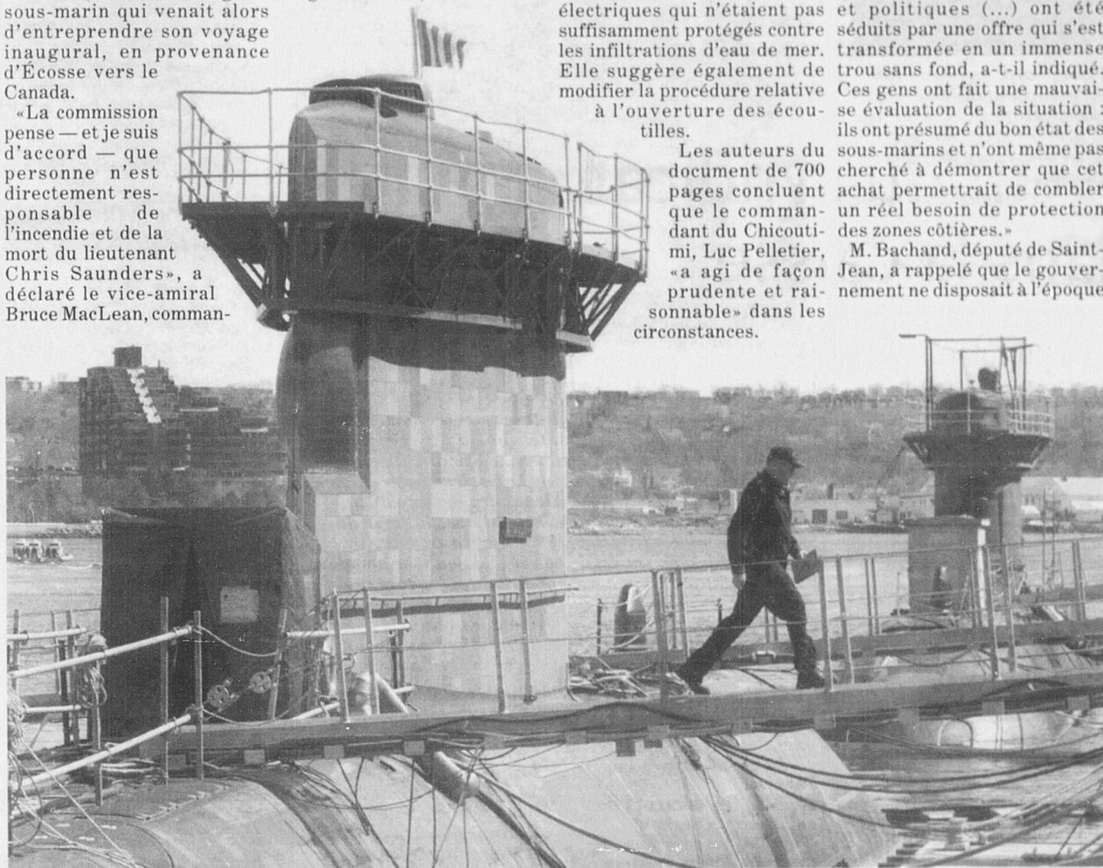
SOUS-MARIN - Dans son rapport, la marine recommande notamment d'améliorer l'isolation des fils électriques du Chicoutimi qui n'étaient pas suffisamment protégés contre les infiltrations d'eau de mer.
