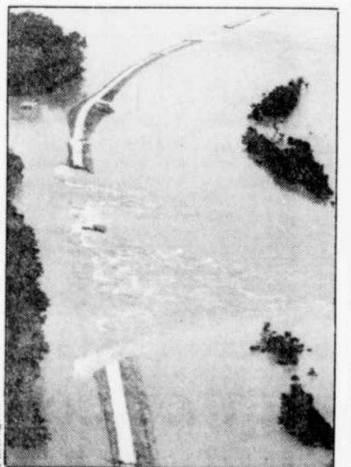
Cette vue aérienne permet de constater l'ampleur des dégâts causés par l'effondrement hier, de plusieurs digues, dans la région de Valmeyer.
