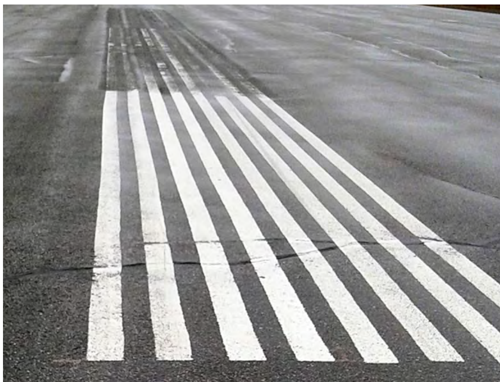
Figure 74 – Dégradation prématurée du marquage effectué directement sur la zone effacée avec de l’eau sous haute pression (haut de la photo)
