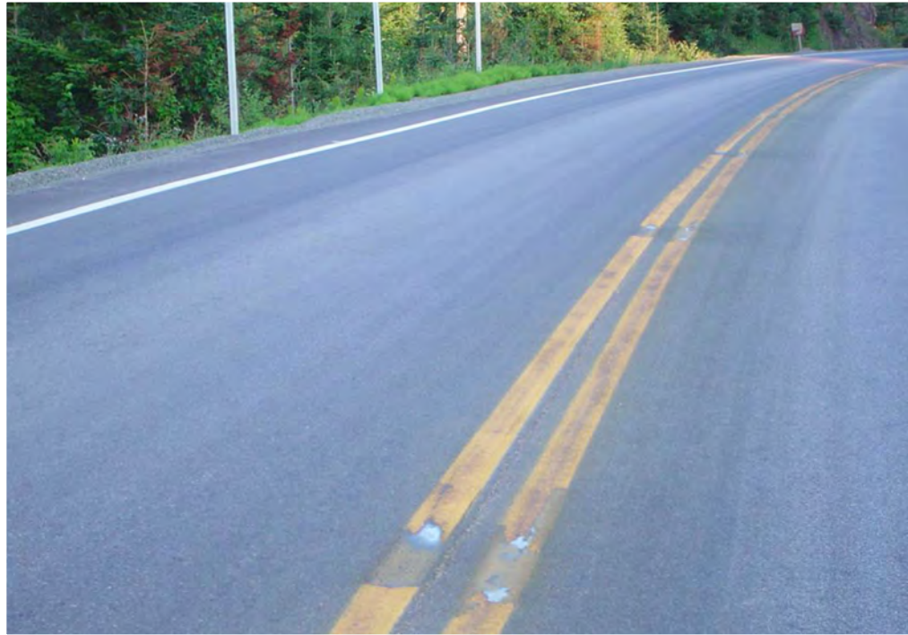
Figure 55 – Problème récurrent de mauvais mélange (coup de pompe du camion traceur)
