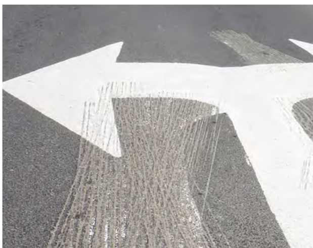
Figure 81 – Exemple d’effacement non conforme avec une rectifieuse (vue rapprochée)
