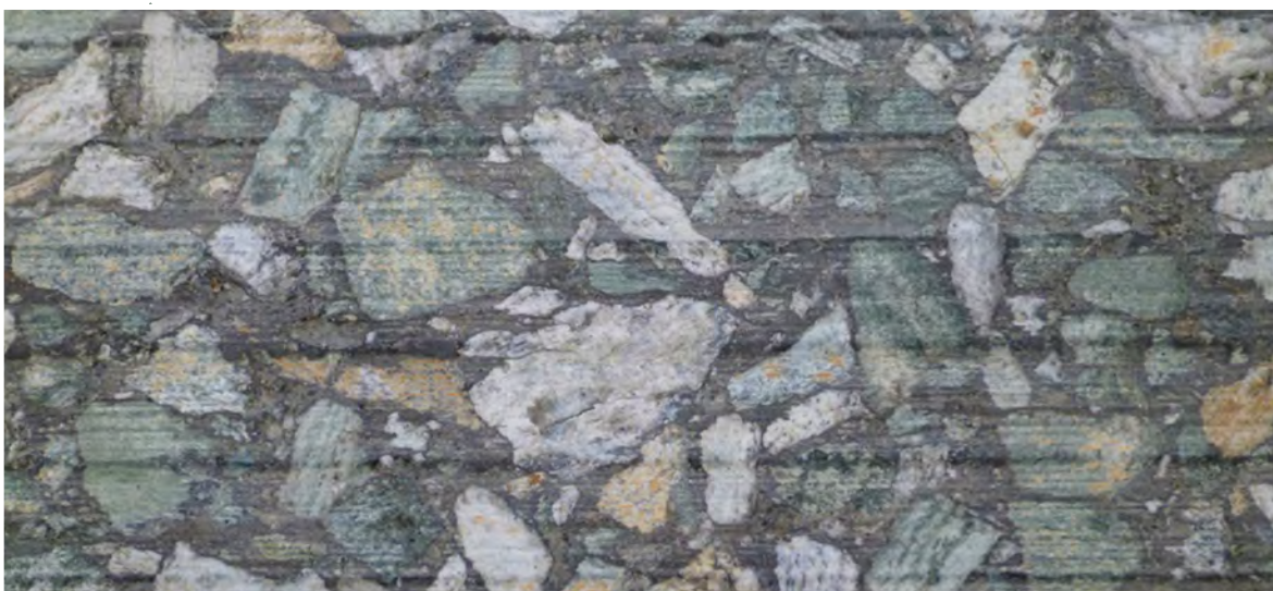
Figure 32 – Exemple d’incrustation au fini lisse conforme (vue rapprochée)
