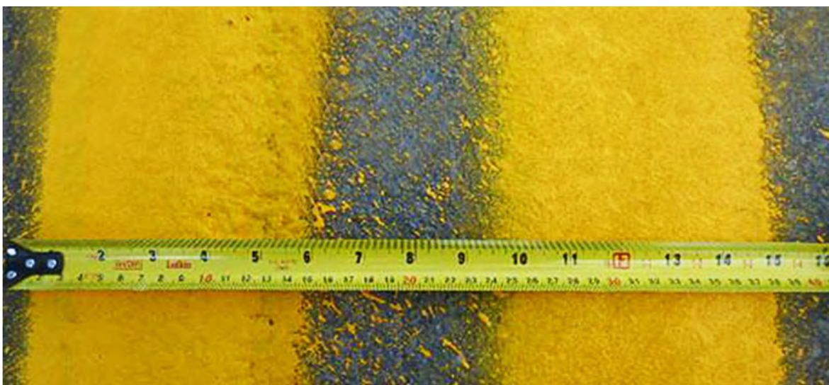
Figure 21 – Exemple de lignes continues doubles trop larges et pas assez espacées
