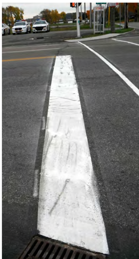
Figure 57 – Phénomène de noircissement d'une ligne d'arrêt (exemple 2)
