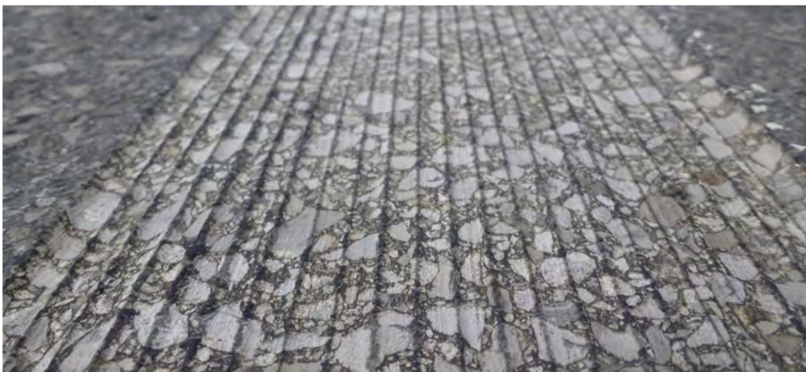
Figure 33 – Exemple d’incrustation au fini inégal avec des crêtes (non conforme)
