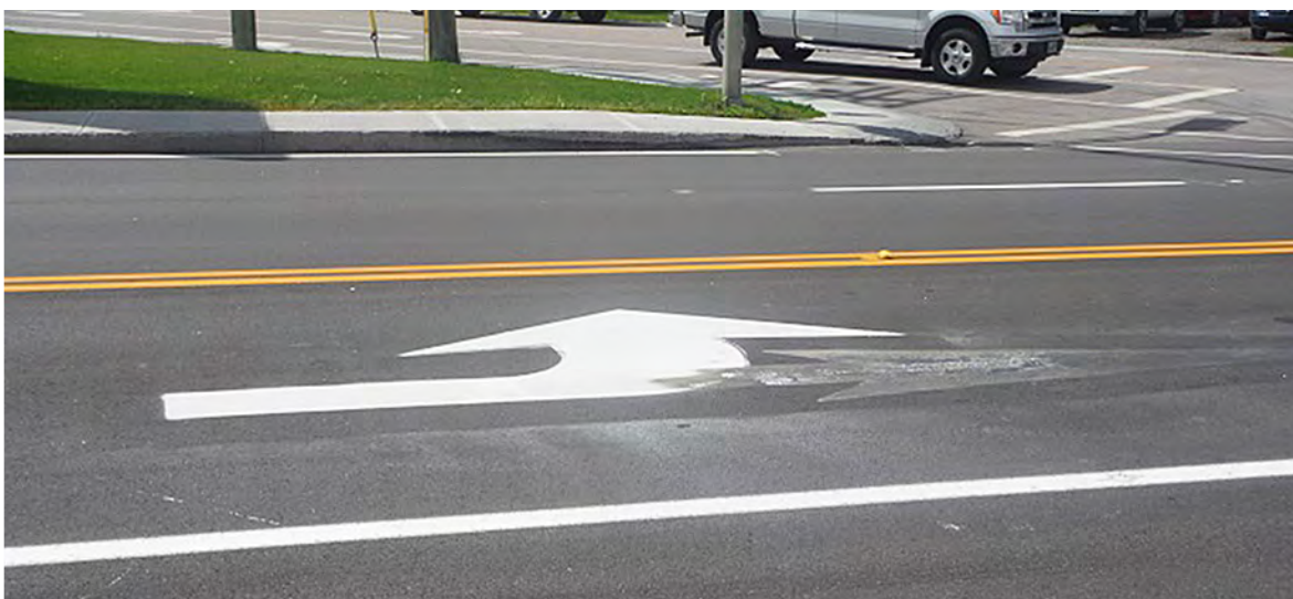
Figure 58 – Disparition d’une partie du symbole (exemple 1)
