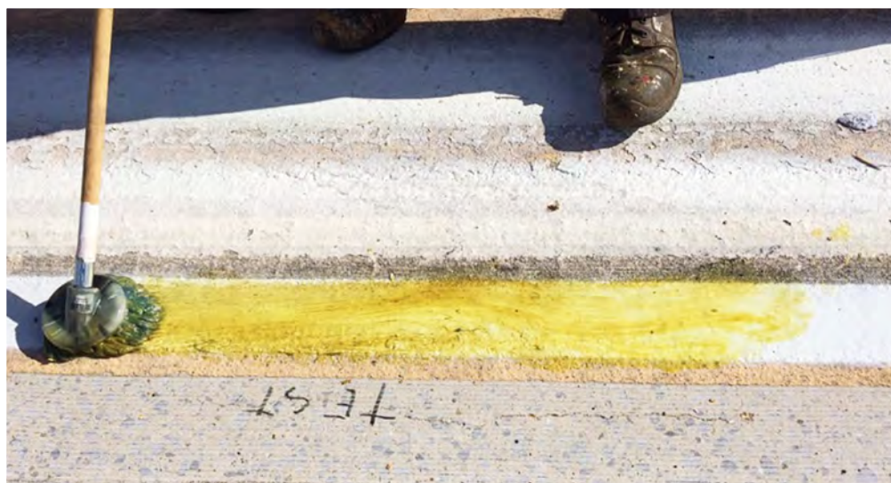
Figure 82 – Exemple d’effacement avec un décapeur chimique (non conforme)
