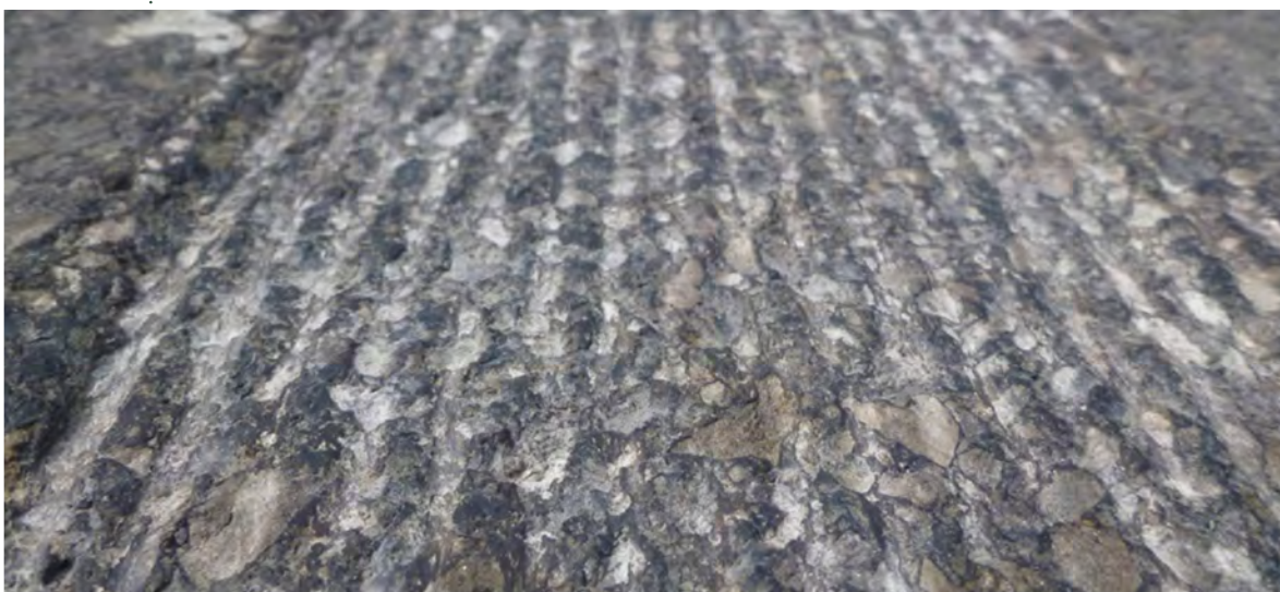
Figure 34 – Exemple d’incrustation au fini rugueux (non conforme)
