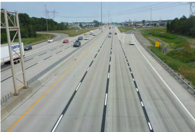
Figure 1 – Produit à base de résine époxydique bicouche sur chaussée de béton
