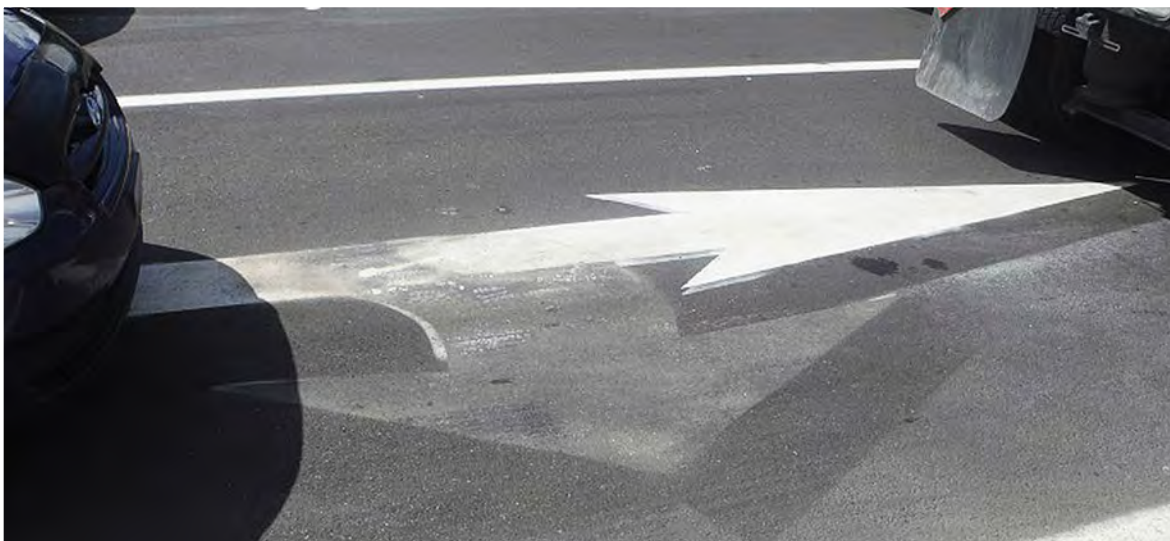
Figure 59 – Disparition d’une partie du symbole (exemple 2)
