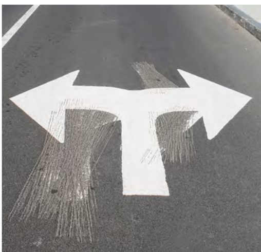
Figure 80 – Exemple d’effacement non conforme avec une rectifieuse
