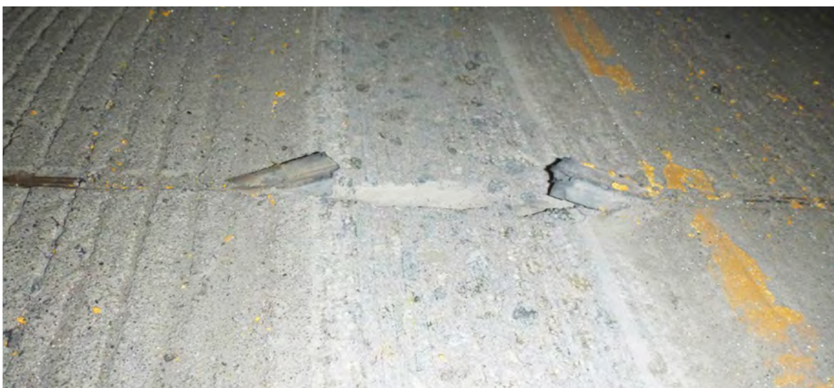
Figure 44 – Arrachement du produit de colmatage prémoulé
