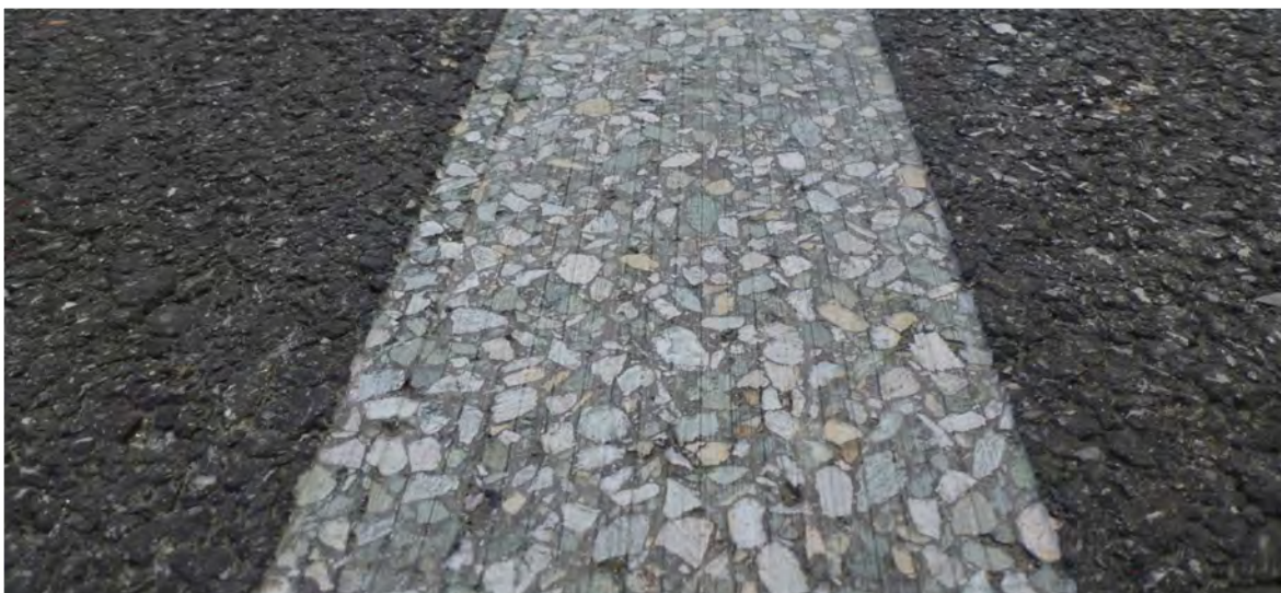
Figure 31 – Exemple d’incrustation au fini lisse conforme
