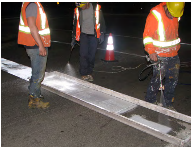
Figure 4 – Application de marquage ponctuel avec fusil à pression et gabarit
