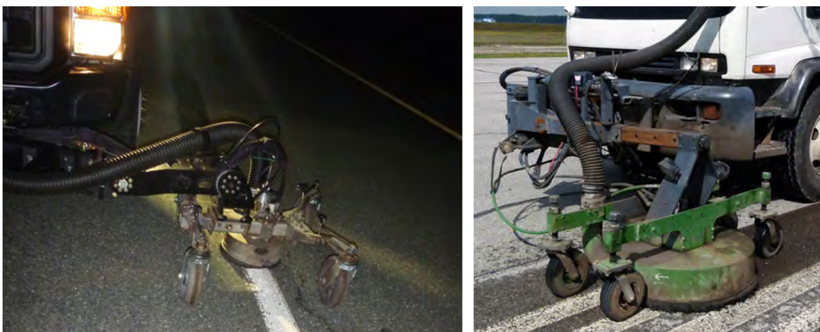
Figure 69 – Exemples d’effacement avec de l’eau sous haute pression
