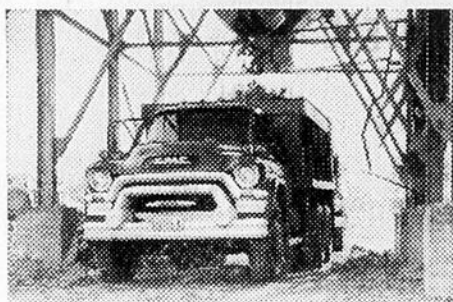
Prêt à recevoir la première charge! La hotte s'ouvre et ce solide camion GMC reçoit des masses de roches. 14½ tonnes de pierre à chaux représentent une lourde charge... mais il est construit pour résister à tout!
