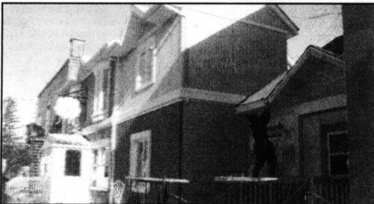
Le centre de la petite enfance Abracadabra d'Orms town se prépare à faire peau neuve. Depuis le 3 octobre dernier, des ouvriers s'affairent autour de l'édifice qui sera rénové et grandi. (photo P.L.)
