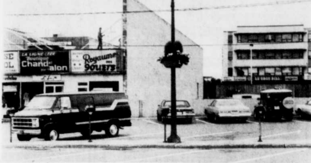
Le projet de construction de $1,500,000 a été abandonné au profit d'un immeuble plus modeste qui se dressera sur les ruines de l'ancienne clinique. Le déblaiement est complet et le coupe feu est terminé.
