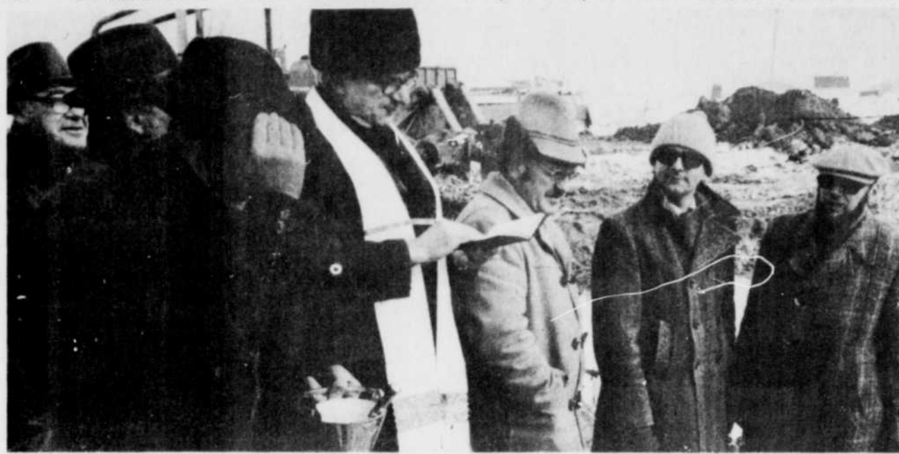
C'est au milieu des fondations et des béliers mécaniques que le curé de St-Bonaventure, l'abbé Théophile Côté, a béni hier matin les travaux de construction de l'église paroissiale, détruite par une tornade le 24 juillet 1975. (Photo La Tribune, par Gérald Prince)
