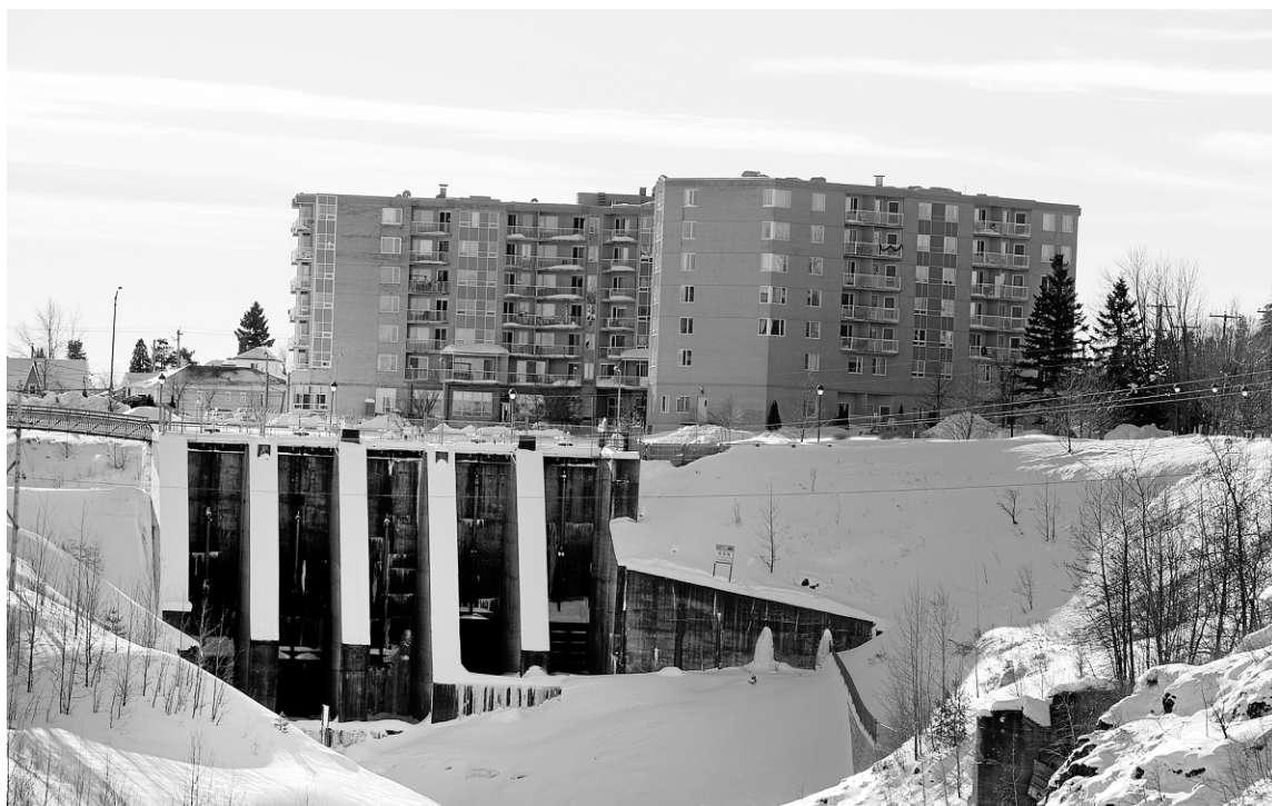
Hydro-Québec a conclu 58 contrats d'achat d'électricité avec des producteurs privés à partir du début des années 90. Une dizaine de ces contrats d'une durée de 20 ans arrivent à échéance en 2014.
