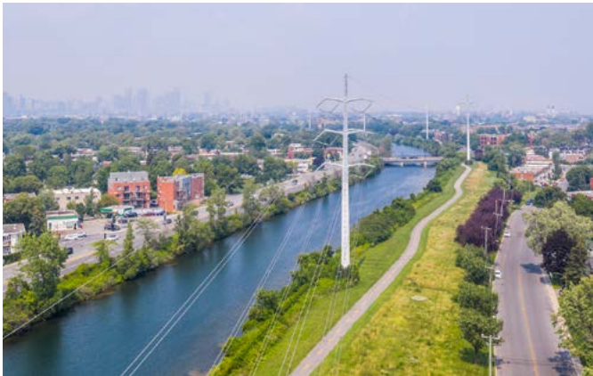
Figure 3 : Aménagement d'une piste cyclable dans l'emprise d'une ligne à 315 kilovolts
