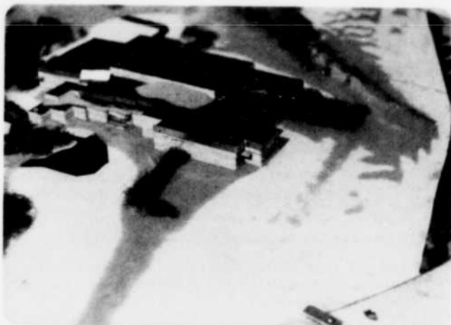
Photo 5 – Disposition de la neige en avant de l'édifice avec les mesures de protection préconisées, tempête d'est.
