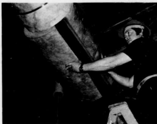
Isolant monopièce en fibre de verre Micro-Lok 650 sur conduites de vapeur de 10" à la centrale électronucléaire.
