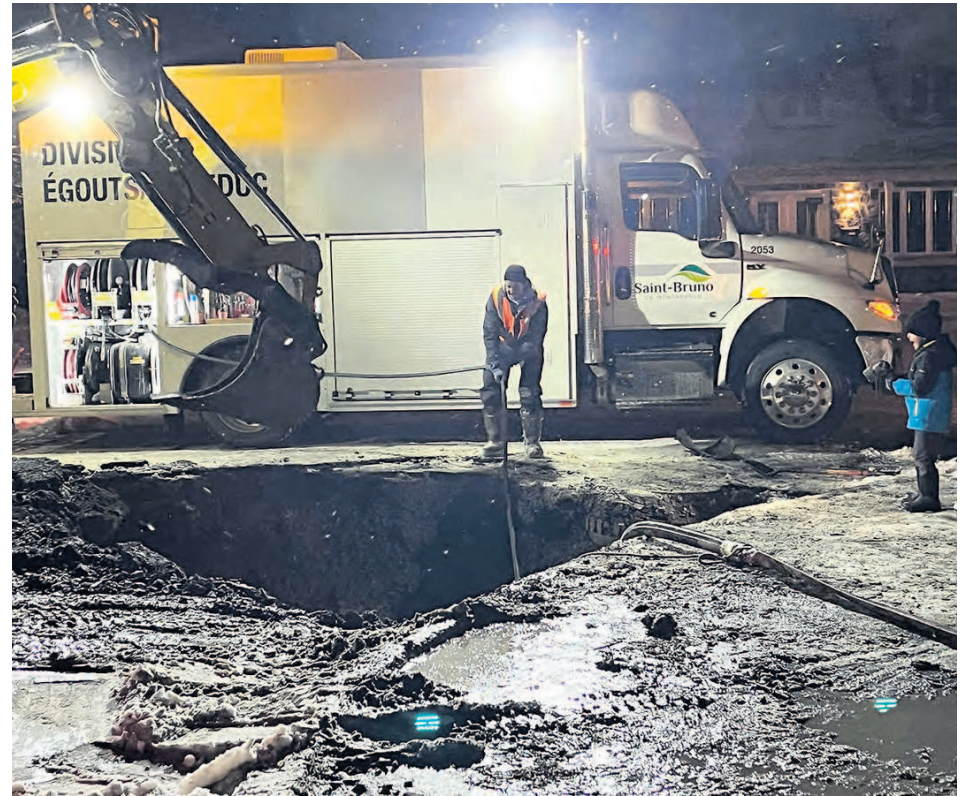
Les travaux publics de la Ville sont à pied d'œuvre pour réparer ce bris d'aqueduc. (Photo : courtoisie)
