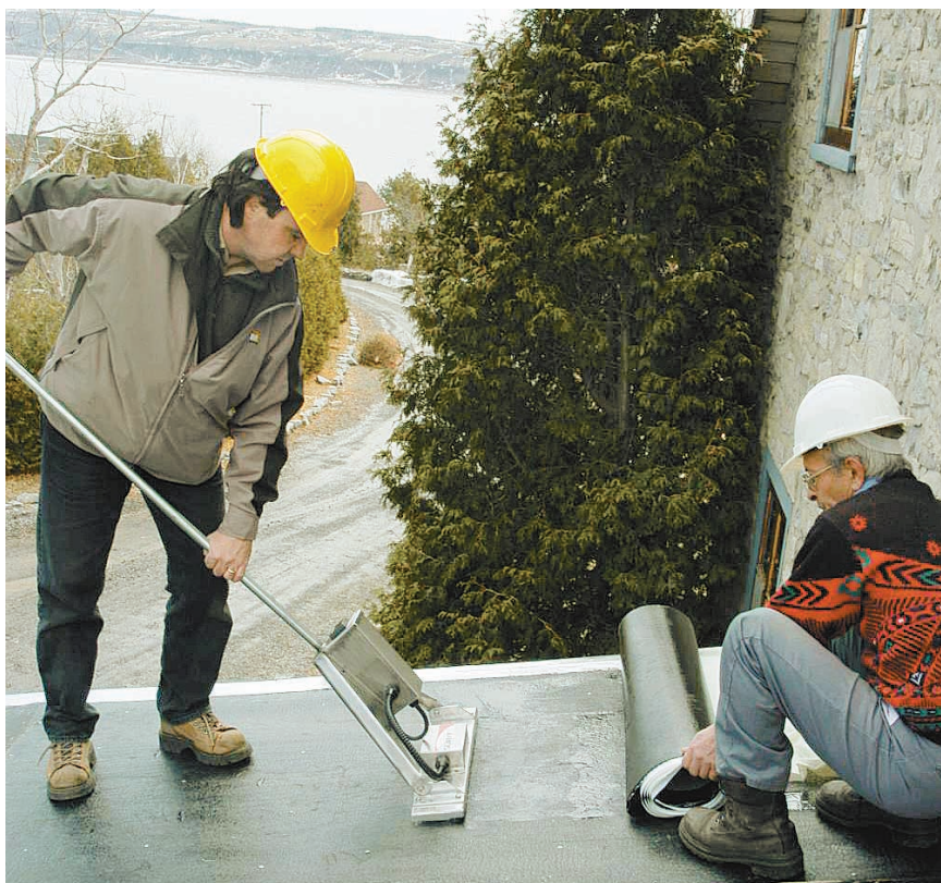
Denis Faucher active une membrane autocollante avec un fer chaud de sa conception, sur la toiture d'une maison de la région de Québec. Cet instrument rend possible la pose de ces membranes par temps froid.
