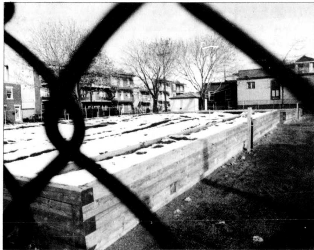
Sur la 1 re Rue dans le quartier Limoilou, depuis 1999, un jardin communautaire est aménagé sur un terrain pollué. Pour éviter l'absorption par les légumes de substances nocives, la Ville de Québec a installé une membrane imperméable qu'elle a ensuite recouverte d'un mètre de terre cultivable.
