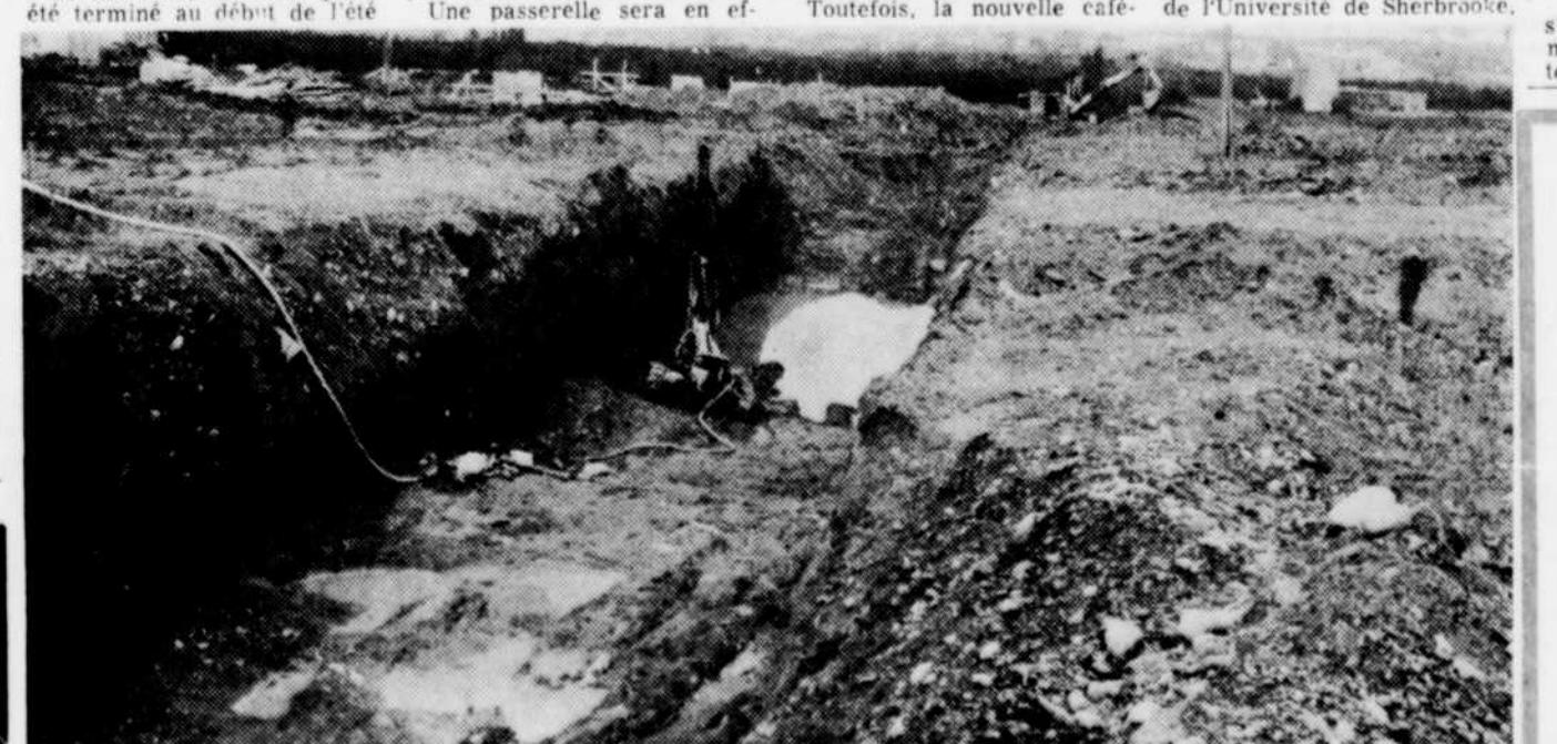
Un autre corridor souterrain est actuellement en construction. (Photo La Tribune, Royal Roy)
