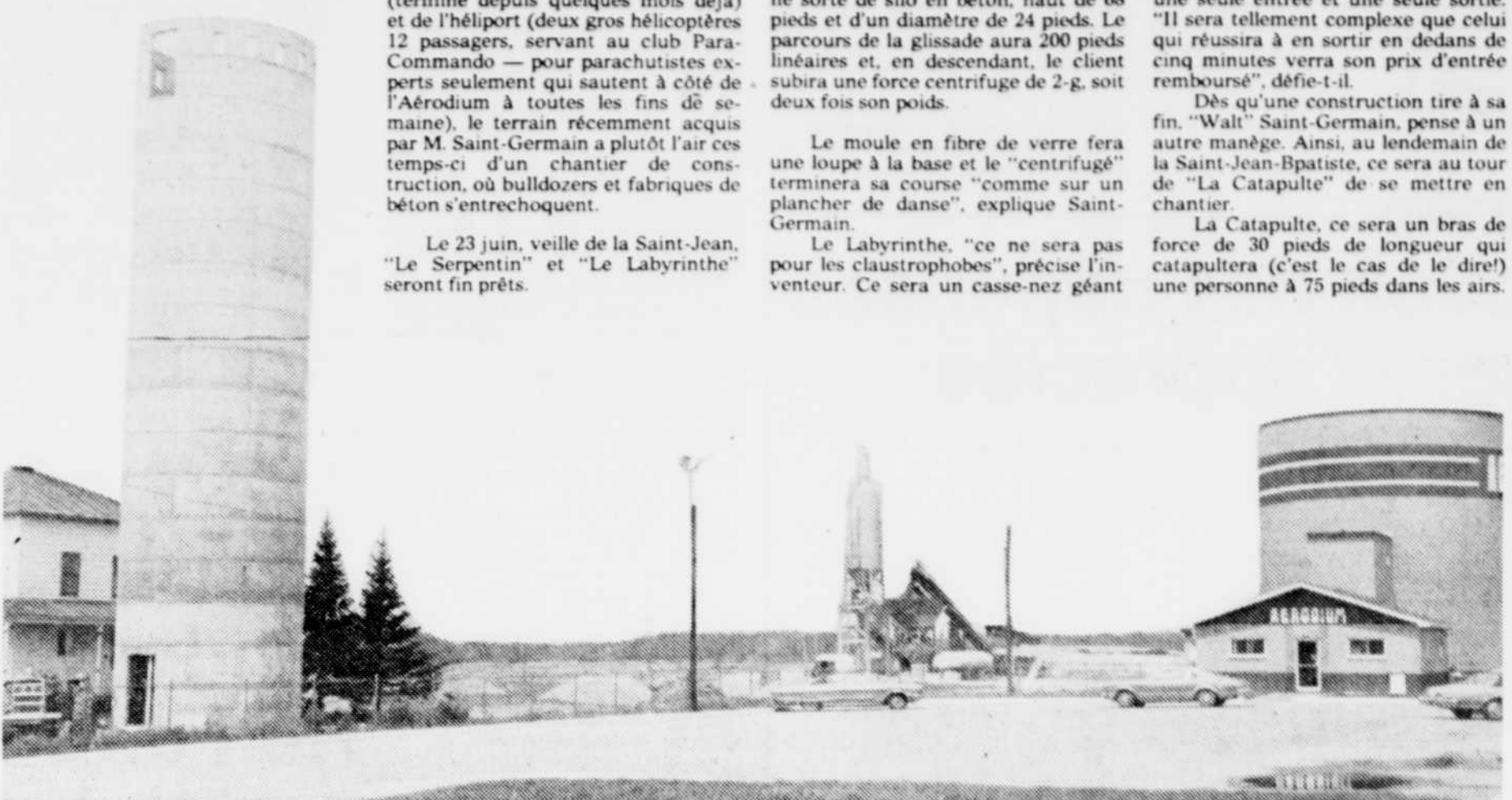
Aires de lancement ou centrale nucléaire? Ce sont les installations de l'inventeur Jean Saint-Germain qui projette de construire au-delà de 500 manèges nouveaux sur le terrain de 9.000.000 de pieds carrés qu'il vient d'acquiescer.
