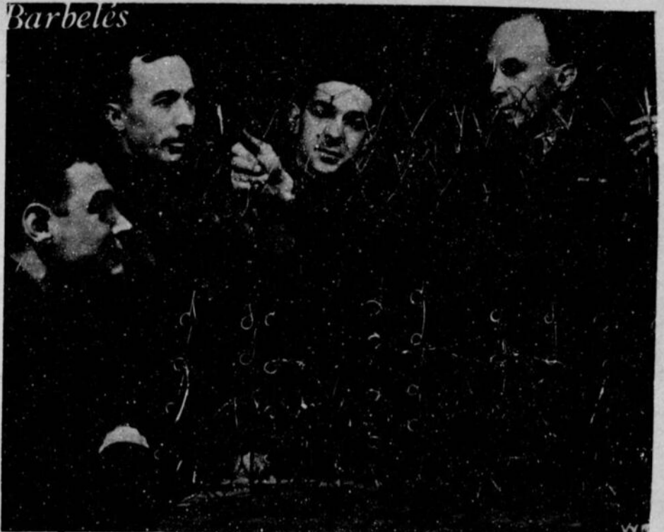
Des recrues du Corps d'entraînement des officiers de l'université McGill apprennent comment enchevêtrer le fil de fer barbelé de façon qu'il obstrue le mieux possible l'avance ennemie
