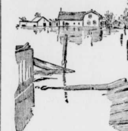
L'INONDATION A BERTHERVILLE — Rues dans l'intérieur de la ville
