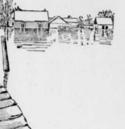
L'INONDATION A BERTHERVILLE — Rues dans l'intérieur de la ville
