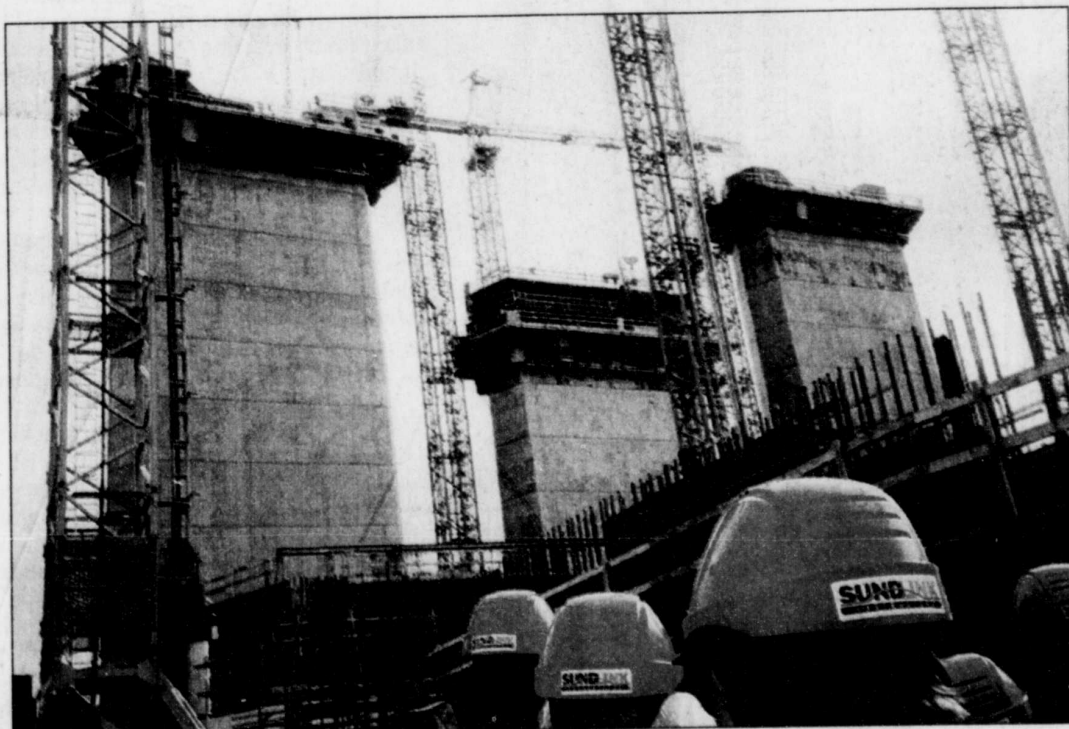
Construction des piliers de béton au port de Malmö.
