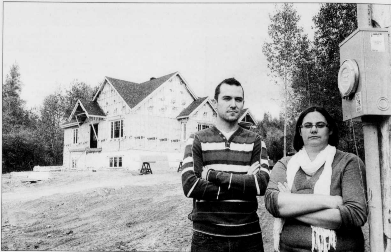
Même si leur maison est toujours en construction, le couple a besoin d'électricité. Les parents de deux enfants souhaitaient déménager dans leur résidence d'ici la fin du mois. Pour accélérer les choses et se conformer à la distance maximale de 100 pieds entre l'entrée électrique et le réseau, le couple avait même planté un poteau au coin de son terrain.
