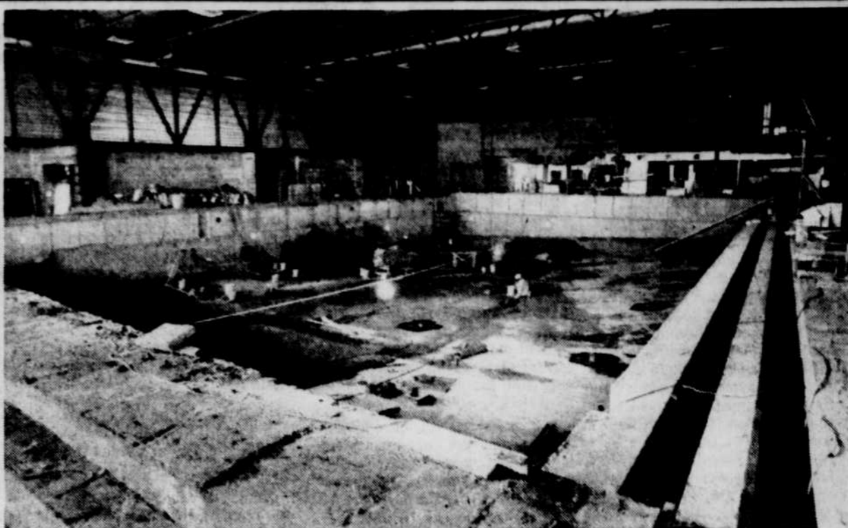
A l'intérieur, les travaux progressent avec un peu de retard.
