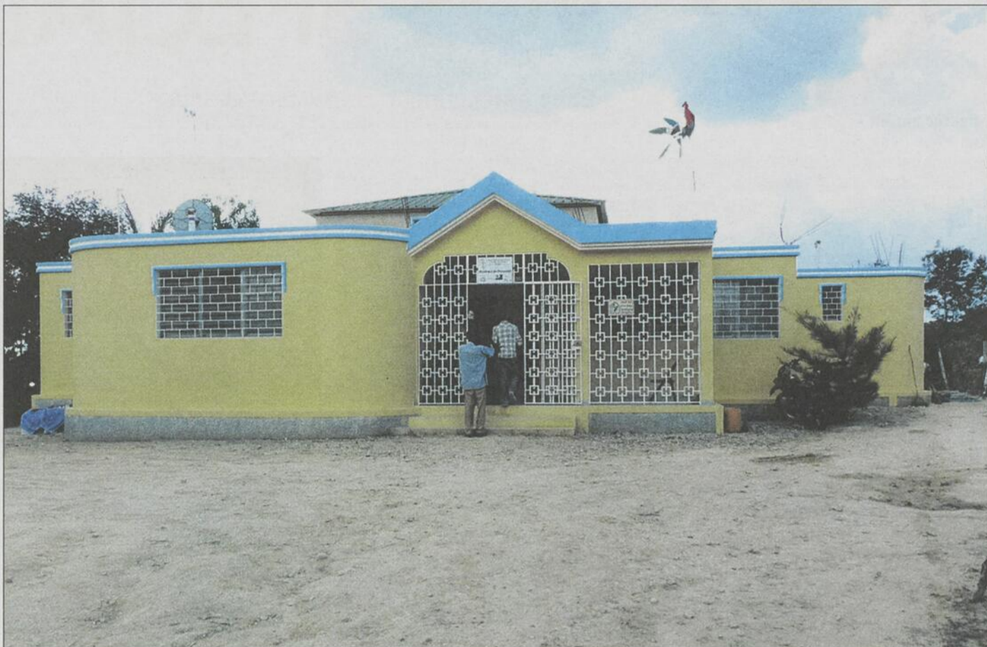
La minicentrale électrique alimentera le centre de santé, l'école, le parc industriel et les résidences de la FODES, à Labrousse.
