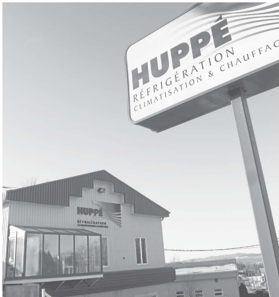
Huppé Réfrigération est situé au 2710, rue King Est à Sherbrooke.
