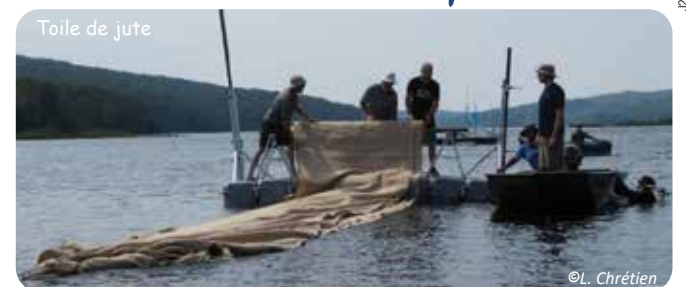
La fixation des toiles sur les sédiments est réalisée par des plongeurs à l'aide de piquets, poids, etc. Il faut s'assurer de ne pas laisser d'espace entre les toiles et vérifier régulièrement qu'elles sont maintenues.
