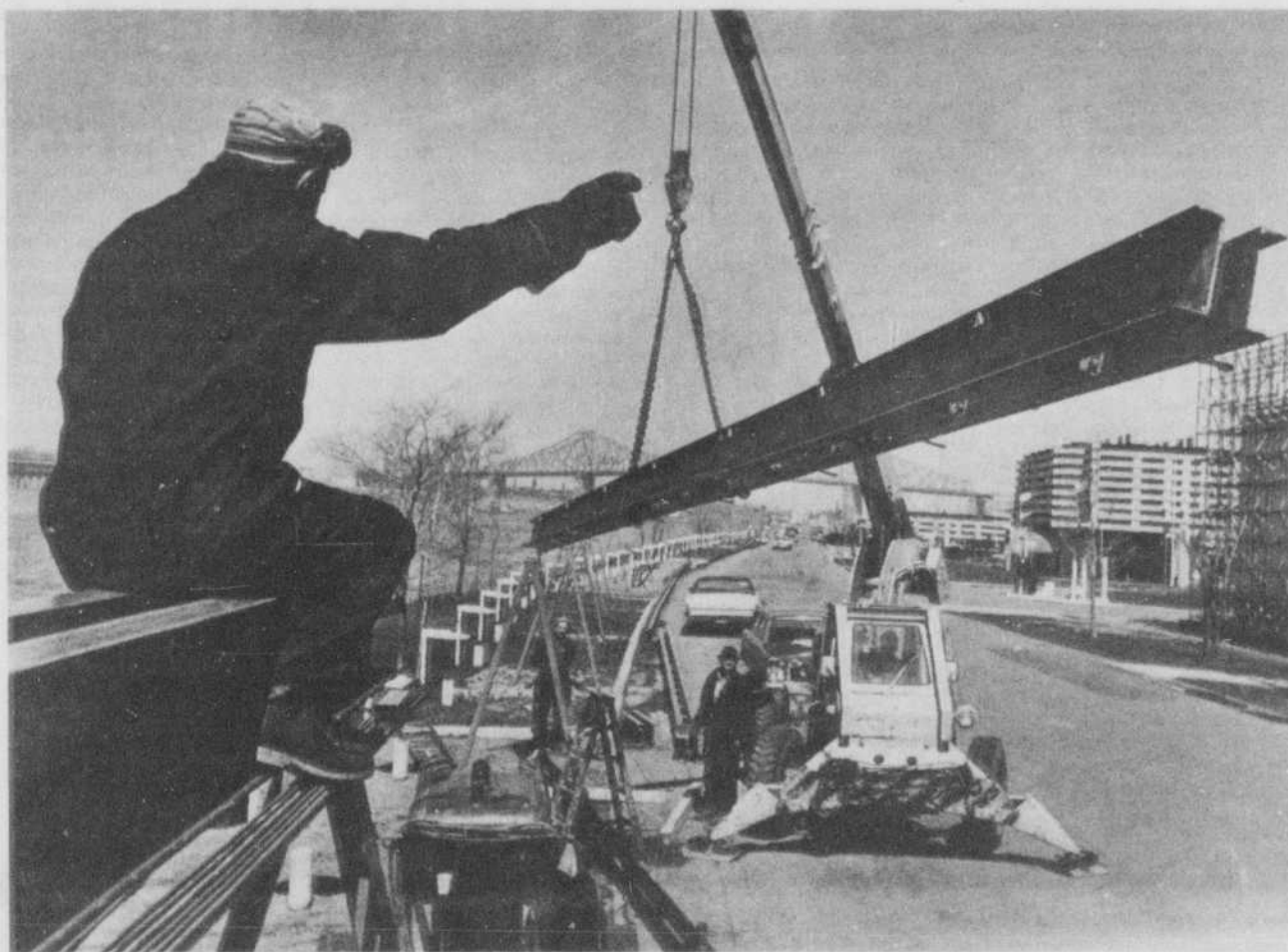
Des ouvriers de Terre des hommes, s'affairent ici à remettre sur la bonne voie, la section du minirail que des vents de 70 milles à l'heure, accompagnés d'un froid de 15 degrés sous zéro avaient renversée l'hiver dernier. Dans quelques semaines, les visiteurs de l'exposition internationale de Montréal pourront à nouveau utiliser le minirail dans les îles, et voir le monde... à 20 pieds d'altitude. (Photo Terre des hommes, par Gordon Beck)
