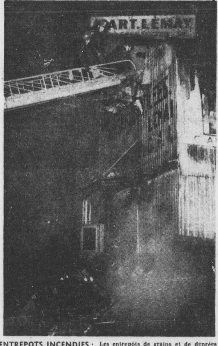
ENTREPÔTS INCENDIÉS: Les entrepôts de grains et de denrées alimentaires G.-Arthur LeMay, situés à 170, rue St-Pierre, ont été détruits par le feu dans la soirée et la nuit de samedi à dimanche. (Photo du "Soleil")
