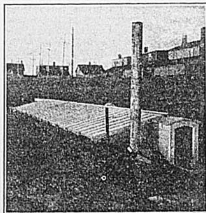
Couche complètement terminée avec son système de chauffage.
