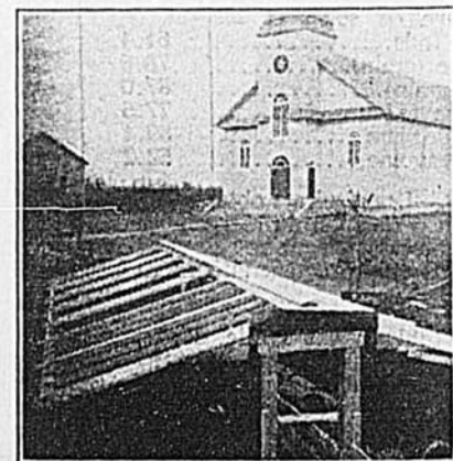
Posage des tuyaux conducteurs de fumée.
