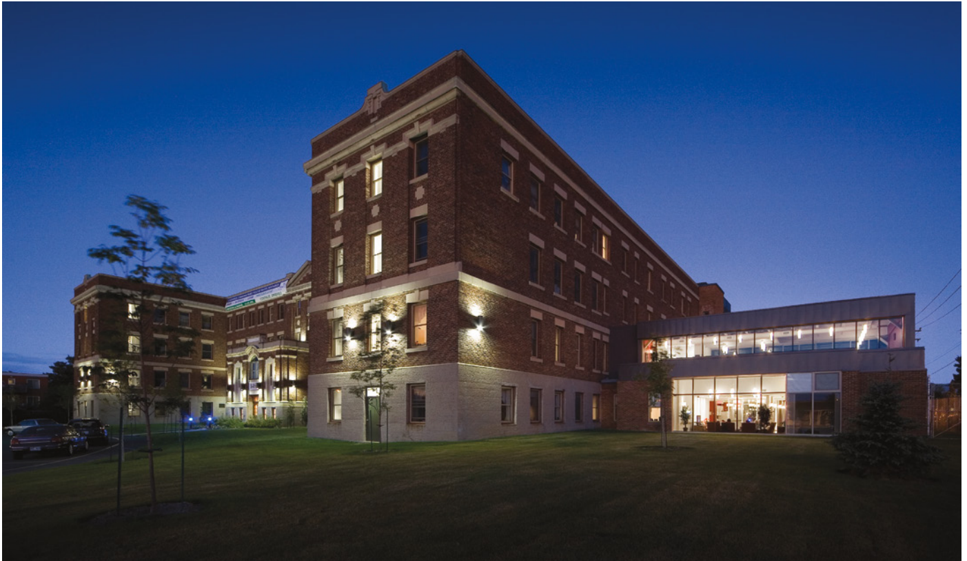
Les aînés en légère perte d'autonomie d'Habitat 1460 ont leurs propres quartiers. Ils partagent cependant les aires communes avec les ménages de la coopérative Rousselot, bâtie sur le même îlot. La partie illuminée en annexe loge notamment le réfectoire.
