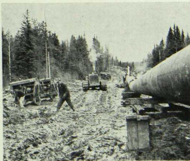
Pose d'un oléoduc en pleine forêt.
