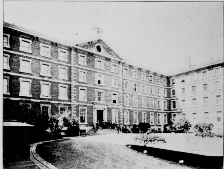
La façade du collège
