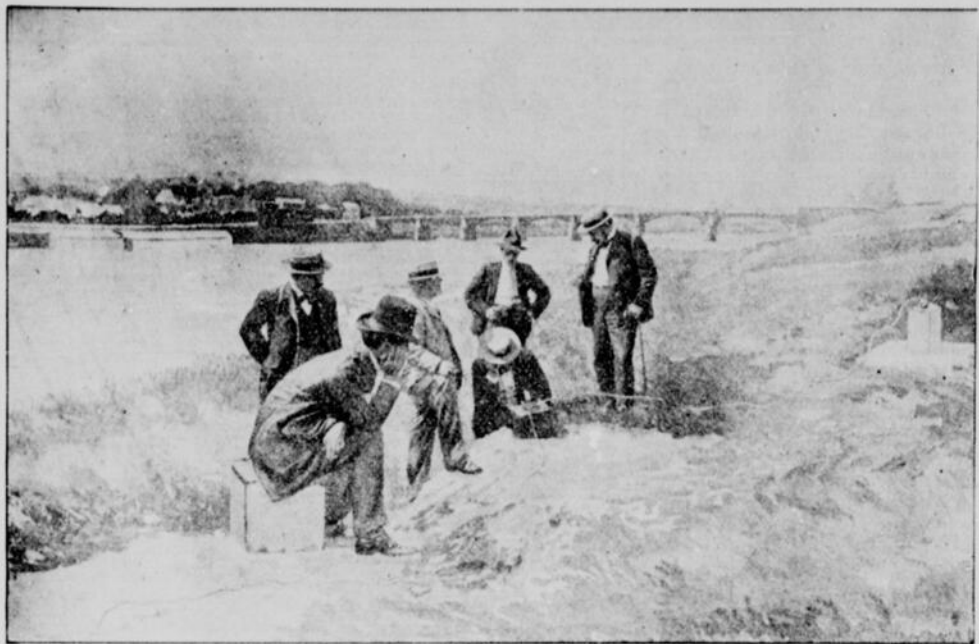
Expérience de télégraphie sans fil par la terre : emploi du radiotéléphone Popoff-Ducretet comme récepteur
