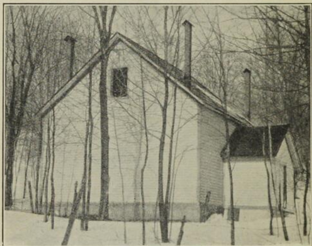
Fig. 158.—Entrepôt frigorifique à l'Institut Agricole d'Oka.
