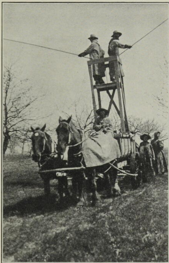
Fig. 102.—Pulvérisations. Nécessité d'une tour pour atteindre les arbres de haute taille. Il est bon de protéger les chevaux avec une couverture cirée.
