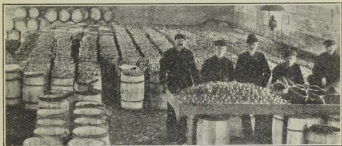
Fig. 134.—Entrepôt d'emballage en Nouvelle-Ecosse.
