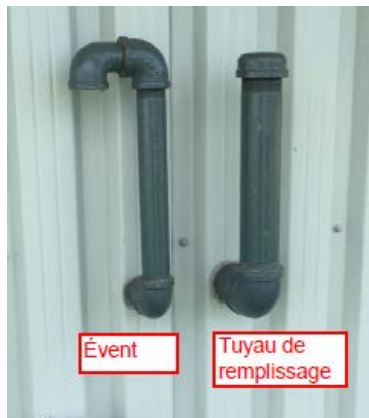
Photo 11 : Dans l'ordre, évent sécurisé avec un coude en U et tuyau de remplissage sans cadenas
