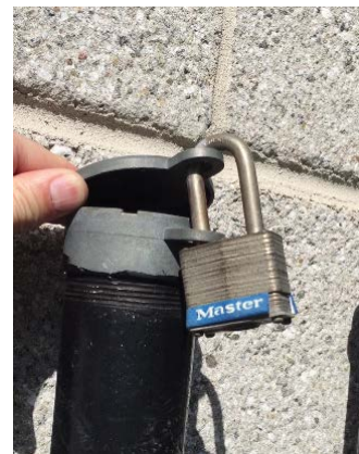
Photo 12 : Tuyau peut être ouvert – cadenas non approprié
