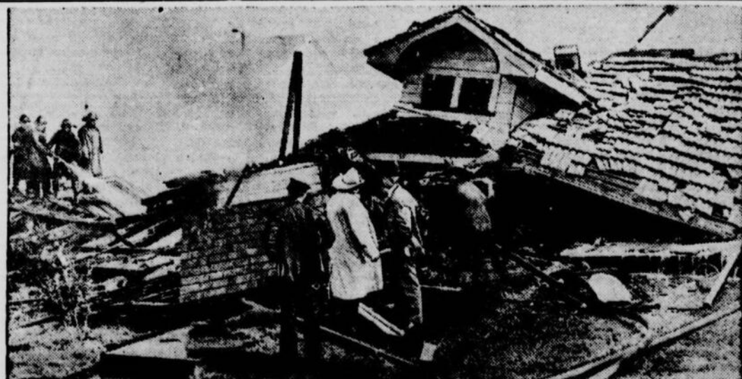
Avec un grondement entendu à deux milles plus loin, une explosion de gaz a démolie cette maison à Rochester, N.Y. Mme George Smith, propriétaire de la maison, se sauva quelques secondes avant l'explosion, chassée de sa maison par les émanations lorsque la conduite à gaz dans la cave se brisa. Personne ne fut blessé.
