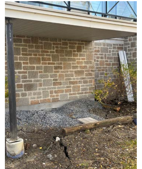
Des poutres d'acier sur du béton soutiennent dorénavant les balcons.
