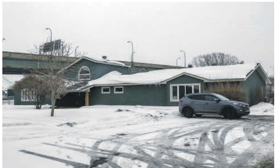
Advenant la concrétisation du projet, la Maison l'Ancrage déménagera dans la Maison des jeunes de Tracy « l'Air du temps » située au 3500, chemin Saint-Roch.
