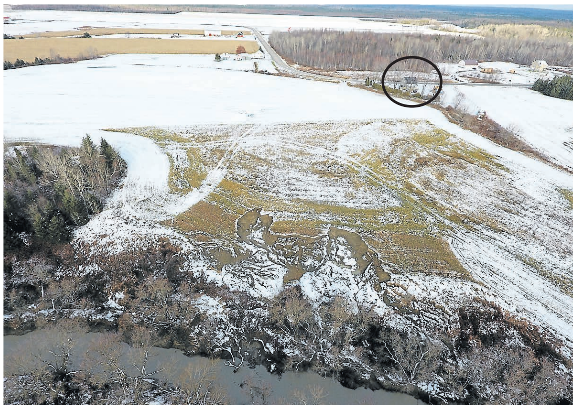
La résidence de la famille (encerclée sur la photo) est la seule du rang des Lahaie qui se retrouve en zone critique de glissement de terrain.
