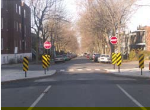
Saillies de trottoirs permettant de réduire la longueur de la traverse piétonnière aux intersections ceinturant l'école Saint-Marc. Rosemont, Montréal.
