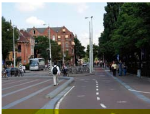
Espace aux abords du Rijksmuseum à Amsterdam aménagé pour favoriser l'accès en transport actif et collectif. Paulaus Potterstraat, Amsterdam.
