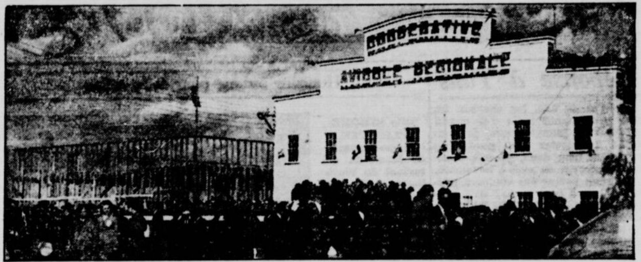
L'édifice principal de la Coopérative Avicole Régionale de St-Damase, dans le comté de St-Hyacinthe, dont la bénédiction et l'inauguration officielle eurent lieu, hier après-midi. A gauche, une bâtisse en construction servira aux fins de livraison des oeufs et de la viande de volaille. Cette coopérative n'est en opération que depuis six mois. Elle a déjà à son crédit un chiffre d'affaires de plus de $200,000. Elle compte à date 358 membres. (Photo la "Patrie").
