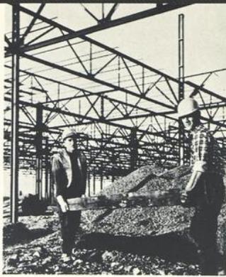
NOTRE COUVERTURE — L'usine GM en construction à Ste-Thérèse embauchera de 1,000 à 2,500 personnes dont la majorité auront été formées dans les écoles de métier du Québec.
